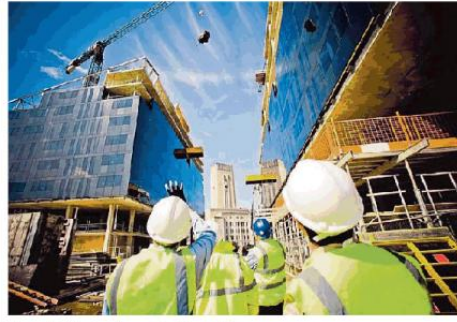
Operai al lavoro in un cantiere edile
